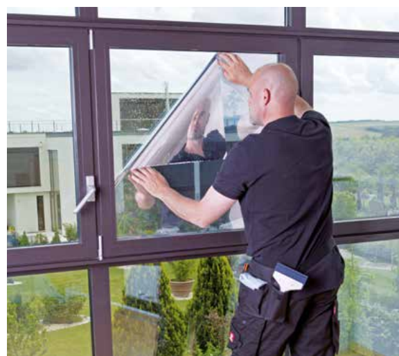
Nachträgliche und fachgerechte Montage von ContraSOL am Fensterglas.
